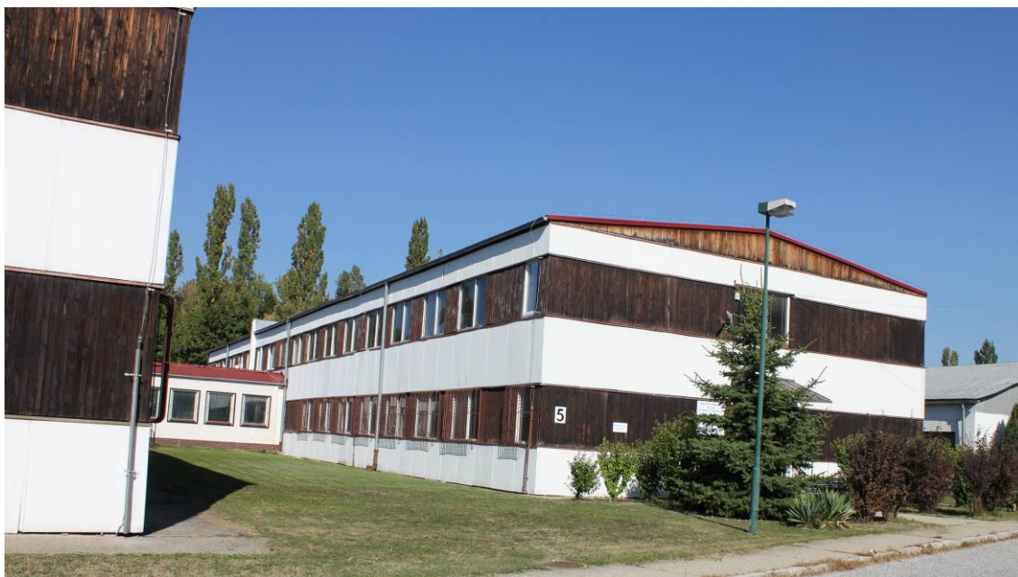
Budovy na Starých Gruntoch prestavané pre potreby knižnice
