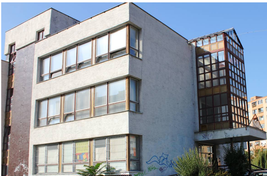
Prístavba ZŠ na Hálovej ulici 16, kde sa na 1. a 2. poschodí nachádzali pracoviská knižnice
